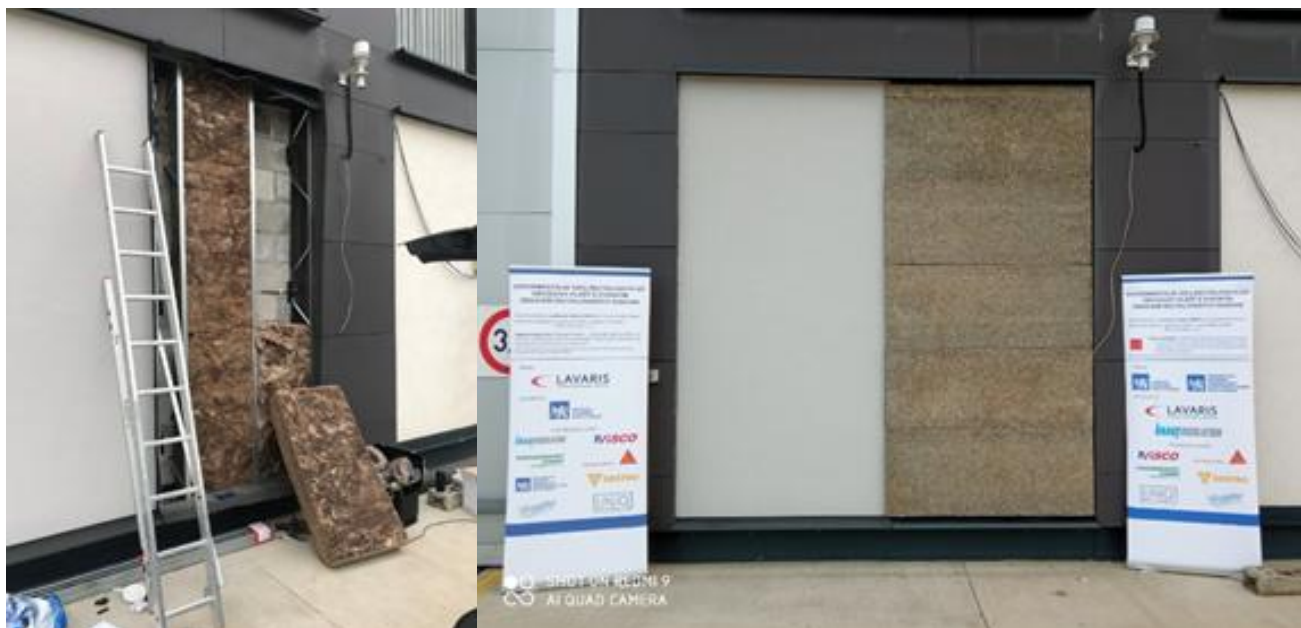
Obrázek 2: Segment obvodového pláště na fasádě budovy UCEEB v Buštěhradu. Dokončená část fasády s KZS a rozpracovaná část provětrávané fasády (vlevo) a finální podoba experimentální fasády (vpravo).
